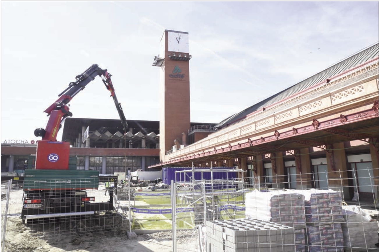
Obras en Puerta de Atocha. Plaza del Embarcadero /ADIF
