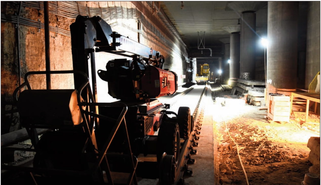
Trabajos en área de túneles
