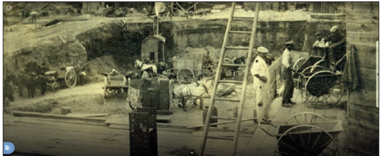
Obreros y carros a caballo durante la construcción de la Widener, circa 1913. Fuente: Archivos de la Biblioteca de Harvard, vía Google Arts & Culture.
