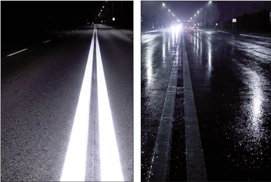
Ilustración 1: Efecto de la humedad y la lluvia en la visibilidad nocturna. A la izquierda, visibilidad en «noche seca». A la derecha, misma marca con humedad (tras la lluvia), el agua que se encuentra sobre la marca hace que esta adquiera un aspecto especular.
