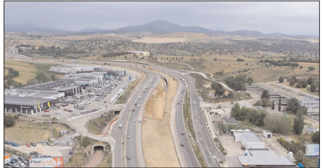
M-121 entre Alcalá de Henares y Alcalá Meco
