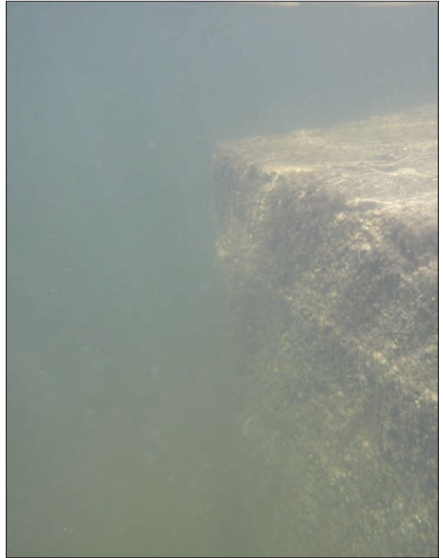
Imagen de dron submarino que muestra el estado de la cimentación inspeccionada
